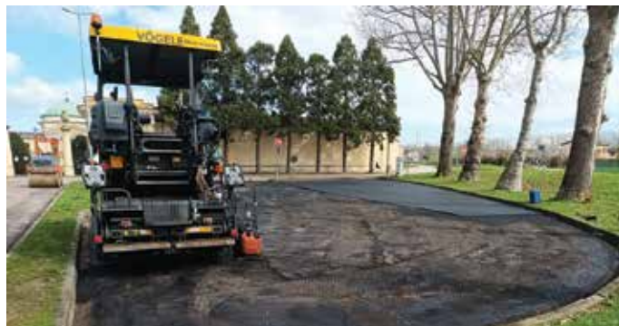
Piazzale del Cimitero di Cento
